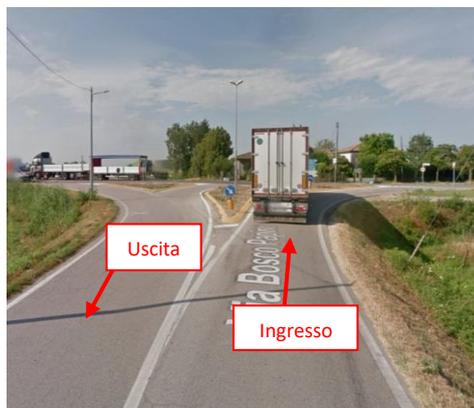
METODO DI MISURAZIONE: ANGOLO TRA IL PERCORSO DI INGRESSO E IL PERCORSO DI CIRCOLAZIONE DELLA ROTATORIA
