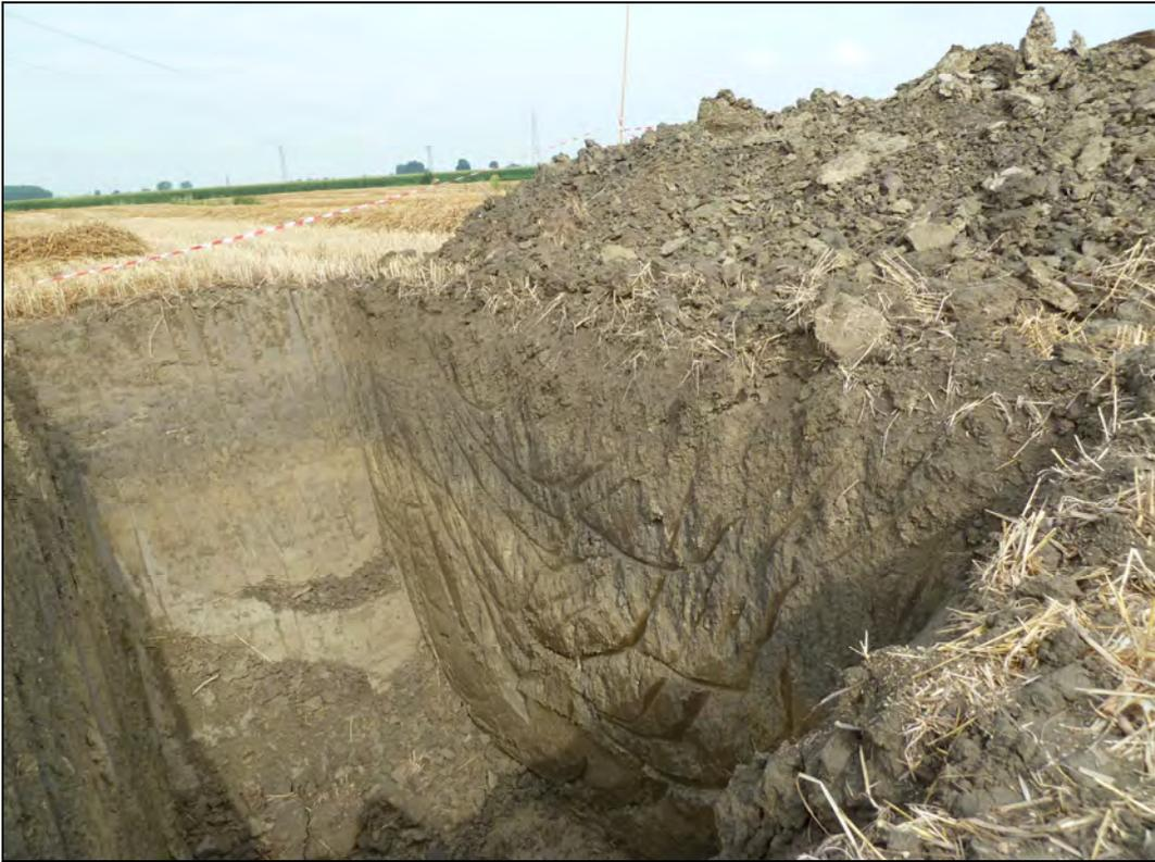
*Figura 3: stratigrafia del terreno all'interno dello scavo – pareti 1 (sn) e 2 (dx)*
